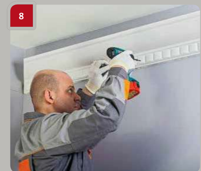
8 Mit der Schraubpistole das Produkt mit Schneidschrauben befestigen (Abstand = 600 mm).
