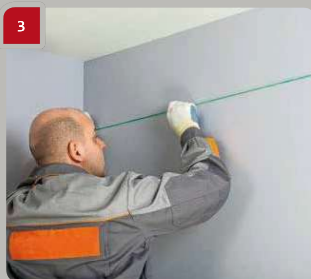
3 Verbinden Sie die Markierungen am Raumumfang mit einem Kreidestrich.
