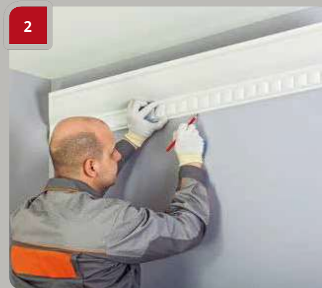
2 Machen Sie eine Markierung an der Unterkante des Produkts.
