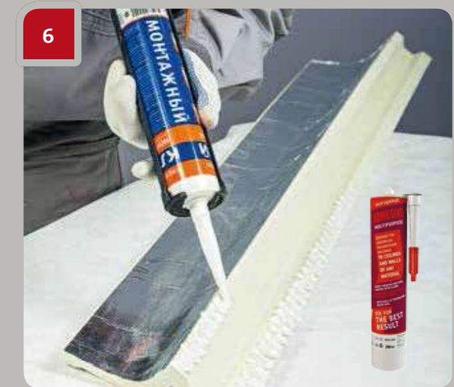
6 G06M290 Kleber auf die Montagefläche- oder G10U290 Kleber über die gesamte Produktlänge auftragen. Die Dicke der aufgetragenen Klebstoffschicht muss 3-5 mm betragen.
