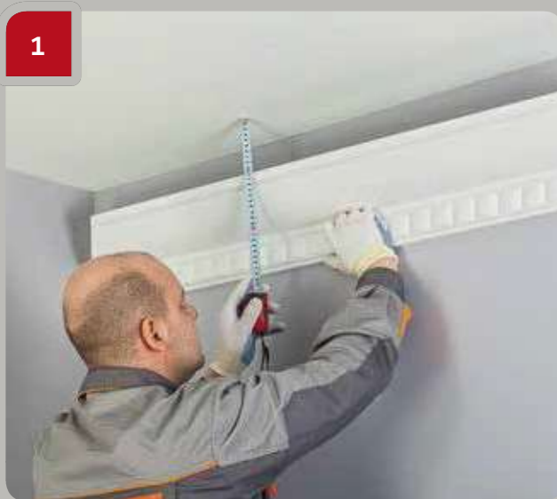
1 Drücken Sie das Produkt fest an Wand und Decke und machen Sie eine Markierung entlang der Unterkante des Produkts.
