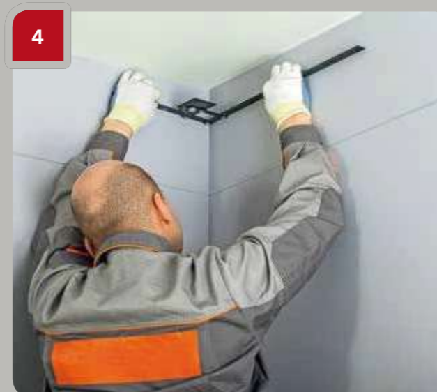
4 Messen Sie mit einem verstellbaren Winkelmaß die Winkel des Raumes.
