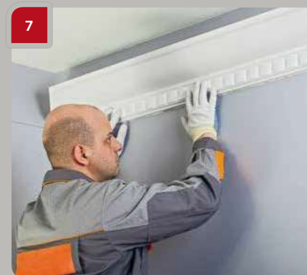
7 Befestigen Sie das Teil an der Montagestelle, indem Sie die zuvor an der Wand angebrachten Markierungen als Richtwerte verwenden. Drücken Sie das Teil über die gesamte Länge an, so dass der Klebstoff aus der gesamten Fläche austritt.
